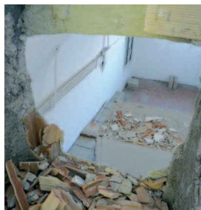
allargamento del foro di accesso
