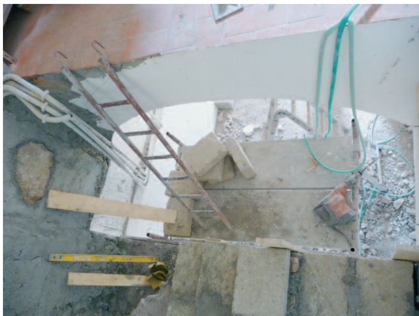
allestimento della scala di comunicazione
